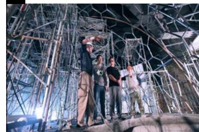
5 Construction Management 工程执行管理
